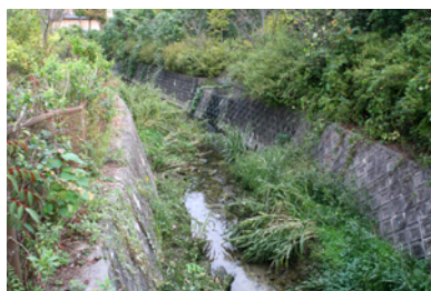
環境整備が望まれる河川
