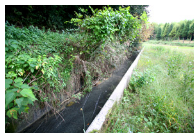
北部清掃工場周辺の排水路
